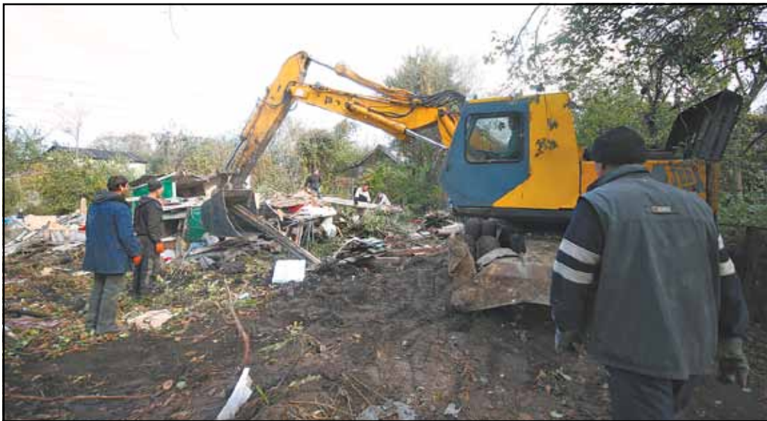
На снос дома уходит 15 минут: сначала валют экскаватором, затем собирают обломки и вывозят.
